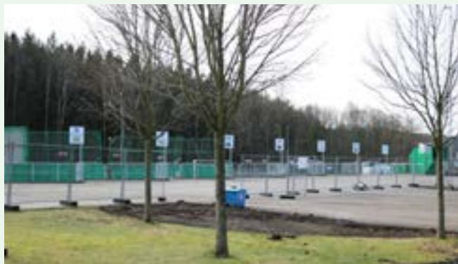
Containrar med olika fraktioner. Mittenområdet är under ombyggnation för att förstärkas med asfalt och ge plats åt vitvaror.
