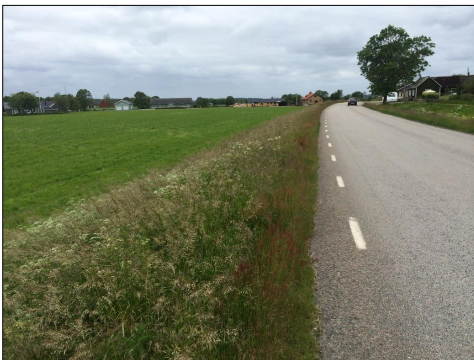
Figur 4. Dike och infiltrationsyta mellan väg och åker
